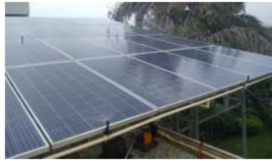
(d) Sprinkler water cleaning
